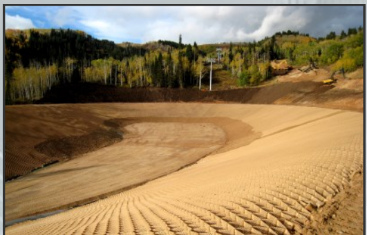
L'intégralité du bassin est protégée par une couche de Bentomat DN, d'un liner texturé de 1,5mm, d'un géotextile 450 g/m 2 et du système de protection de pente GEOWEB® de Presto.
