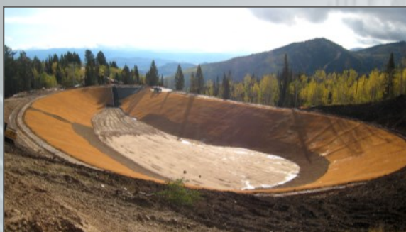
Le système Geoweb, classiquement noir, a été exigé et fourni couleur sable pour ce projet.
