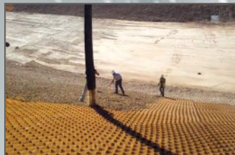
Remplissage des panneaux Geoweb avec des pierres prélevées et concassées sur site.
